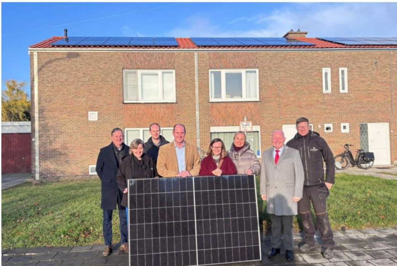
In 't Veldeken kregen de sociale woningen na nieuwe daken nu ook zonnepanelen. © IF
