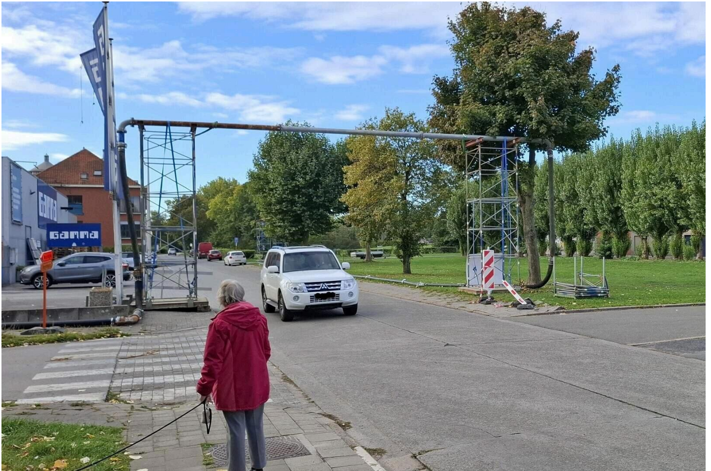
Een bovengronds buizenstelsel voert het grondwater richting zeekanaal. © Emiel Tack
